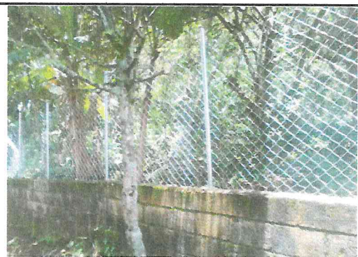
Foto 6: Instalación de malla perimetral
