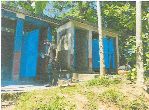
Foto 3: Mantenimiento en puertas de baños
