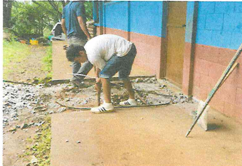
Foto1: Demolición de piso de concreto en pasillos
