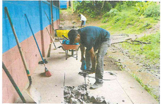
Foto 2: Demolición de piso de concreto en pasillos
